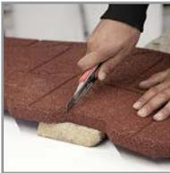
Zum Zuschneiden mit dem Cuttermesser legen Sie die Matte auf eine Latte und drücken sie links und rechts nach unten. Dadurch entsteht eine Dehnung der Matte und sie lässt sich gut schneiden.
